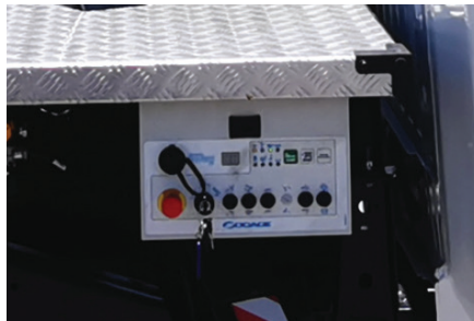
ระบบควบคุมฉุกเฉินของฐานควบคุม
